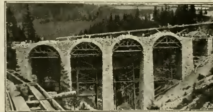
Abb. 130. Ramsaubach-Viaduct im Bau. [Eisenerz-Vordernberg.] [Nach einer photographischen Aufnahme von C. Weighart, Leoben.]
